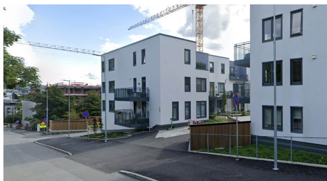
Nyere blokkbebyggelse i Breiviken og Merionkvartalet under bygging, nord for planområdet.
