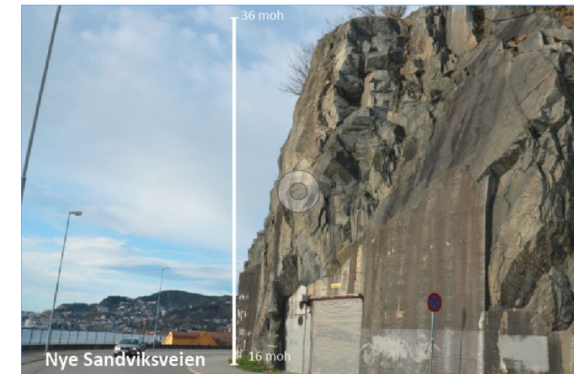
Figur 3 Høydeforskjell mellom Nye Sandviksveien og Rothaugen skole
