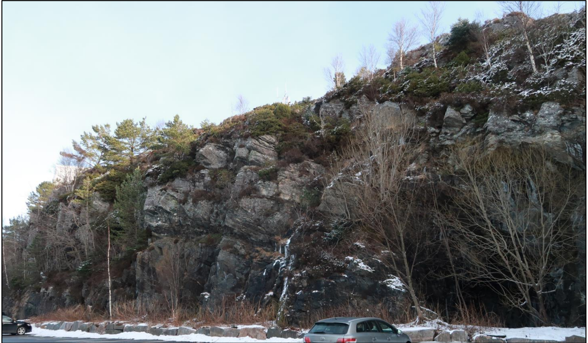
Figur 2. Bilde av deler av prosjektområdet. Hovedsprekkesettet følger foliasjonen og har fall inn i skjæringen. Dette er gunstig for totalstabiliteten.
