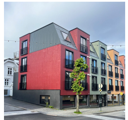
Døme på takopplett som bryt opp eit elles monotont skråtak mot gata.
